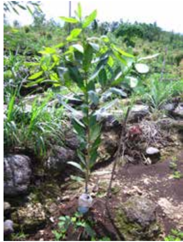
Gambar 30. Pemasangan irigasi tetes
